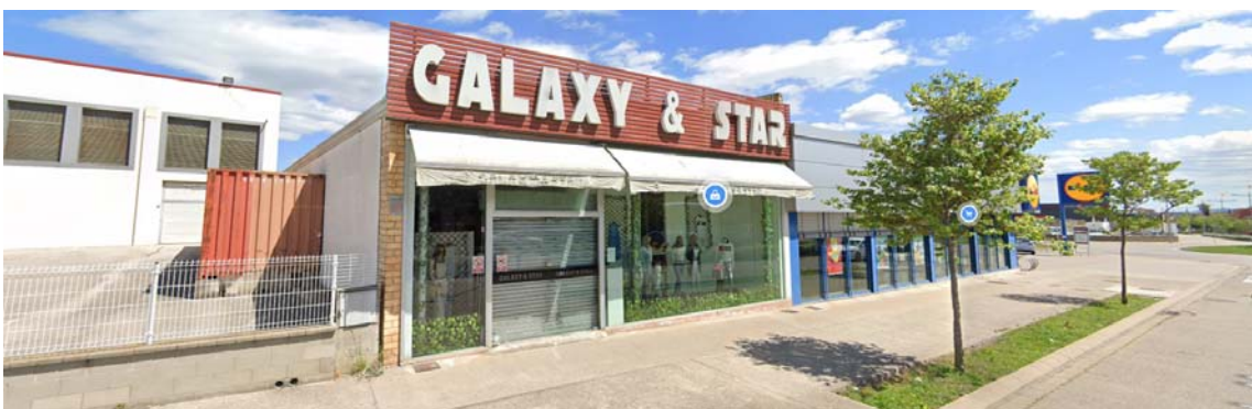
Imatge des del carrer de Mata (cap al sud). S'observa el local comercial alineat a vial i que arriba fins al límit de la parcel·la veïna. Font: Google Maps.
