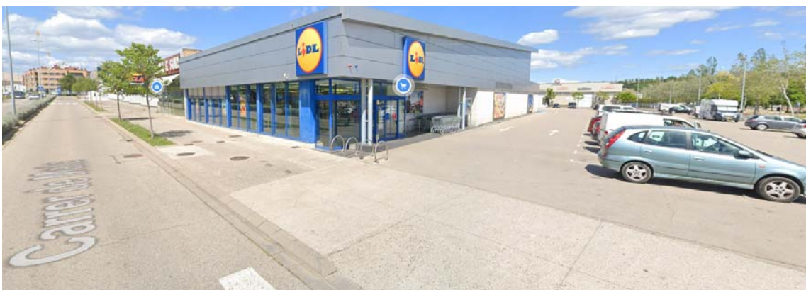
Imatge des del carrer de Mata (cap al nord). S'observa el supermercat que està alienat a vial i l'aparcament del mateix. Al fons s'observa el local comercial. Font: Google Maps.
