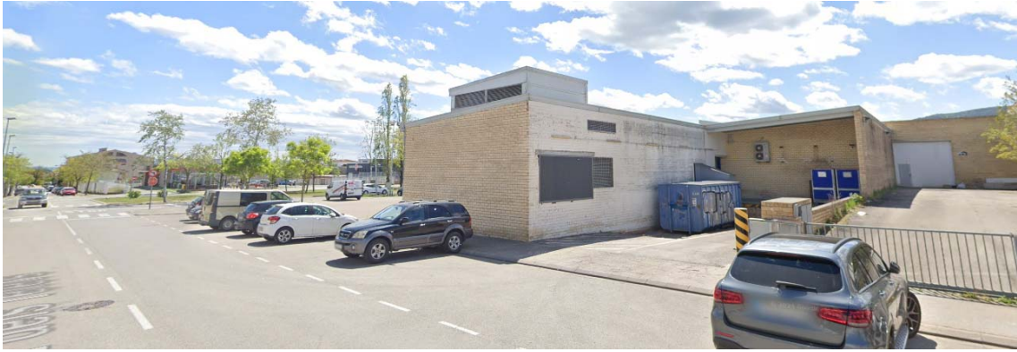
Imatge de l'edifici des del carrer dels Telers. S'observa que l'edifici està parcialment enganxat a la finca veïna i que la càrrega i descàrrega de mercaderies es produeix des del carrer dels Telers. Font: Google Maps.
